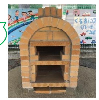
ピザ窯の後ろはアーチの形に合わせレンガを切って 1 つ 1 つ積み並べていきます。最後にピザ窯の頂上に煙突を付 けて完成です!おいしいピザを焼けるのが楽しみです♡
