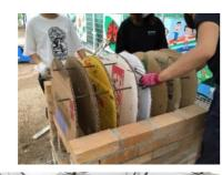
重さで崩れていかないように半円に切った段ボール の形に合わせてレンガを積んでいきました。その間 にセメントを詰め込み、固めることでレンガをアー チ状に積むことができます!しかし段ボールの支え があっても少しずつレンガが重さで崩れていくの で、素早くきれいに積むことが難しかったです。
