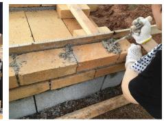
1 段ずつセメントを敷いてはレンガを積み、隙間にもセメント セメントとモルタルを混ぜ、それを 入れて重ねていきます。これを8段作りました!みんな少しず ふるいにかけて火に強いセメントを つ慣れていき、セメントを作る職人や、隙間にセメントを詰める 作りました。地面に穴を掘り、セメ 職人、レンガの上にセメントを敷く職人が生まれました分 ントを敷いて、コンクリートを埋め
